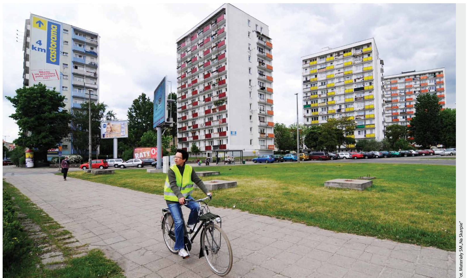
W tym roku zakończona zostanie wymiana term gazowych na Osiedlu Młodych, którą MSM rozpoczęła w 2009 r.
