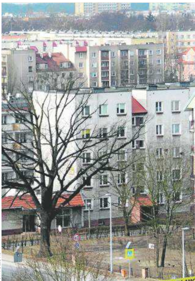
Rada Nadzorcza m.in. analizowała zużycie ciepła w 177 budynkach
