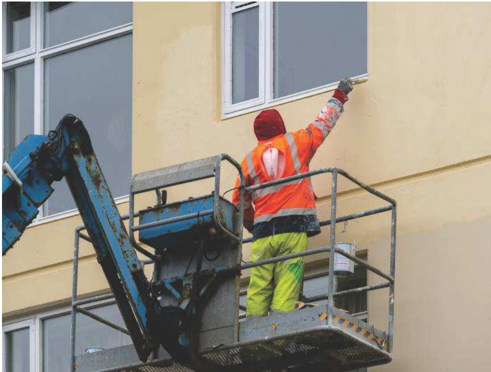
W ramach zaplanowanych remontów, odnowiona zostanie m.in. elewacja w szesnastu budynkach
