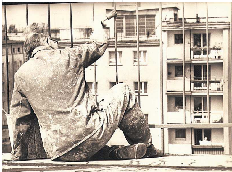
Osiedle Młodych - prace malarskie na balkonie budynku przy ul. Tuwima
