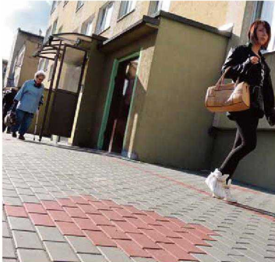
Wyremontowana nawierzchnia pieszojezdni przy ulicy Słowackiego 109-111
