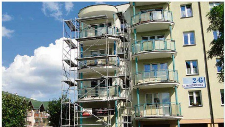
Naprawa balkonów w bloku przy ulicy Witkowskiego 2-6
