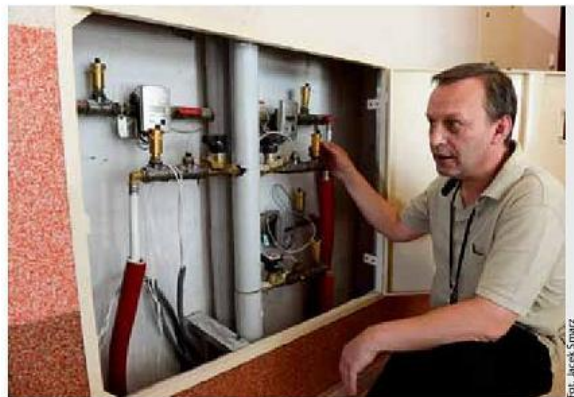
Jacek Kubacki, inspektor ds. technicznych w MSM, prezentuje podzielniki ciepła w bloku przy ulicy Hurynowicz
