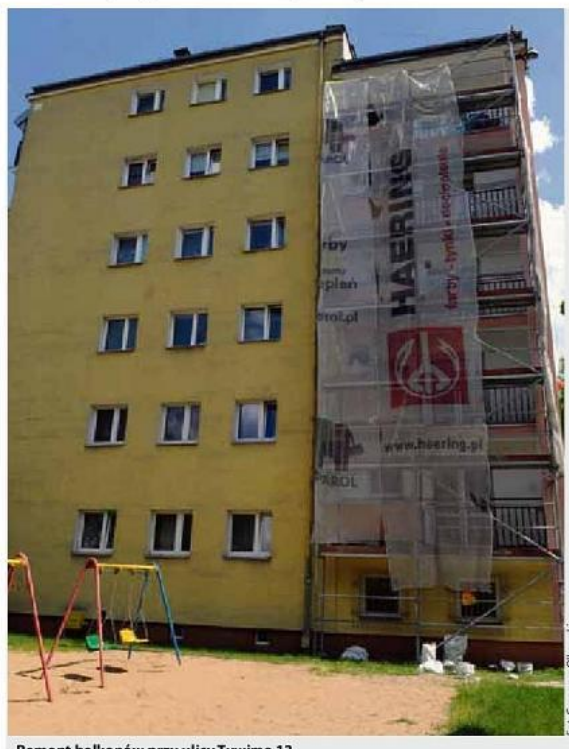
Remont balkonów przy ulicy Tuwima 13
