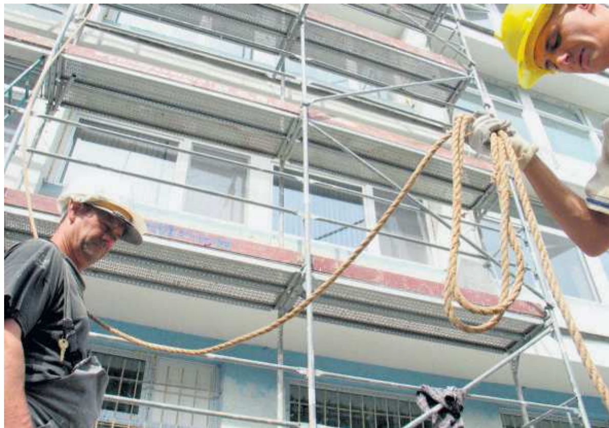
Wszystkie prace remontowe, są dla każdej nieruchomości oddzielnie ewidencjonowane
